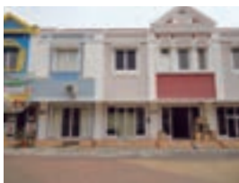
デルタマス事務所の入居ビル
