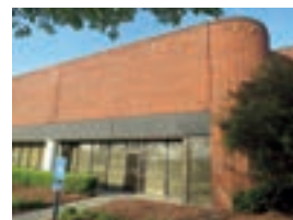
アトランタ事務所の入居ビル
