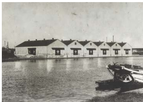
1934年(昭和9年)竣工当時の外観写真
